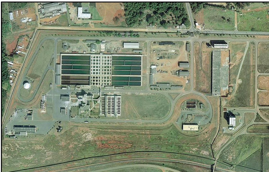
Figura 34: Estação de Tratamento de Água (ETA) Taiaçupeba.
