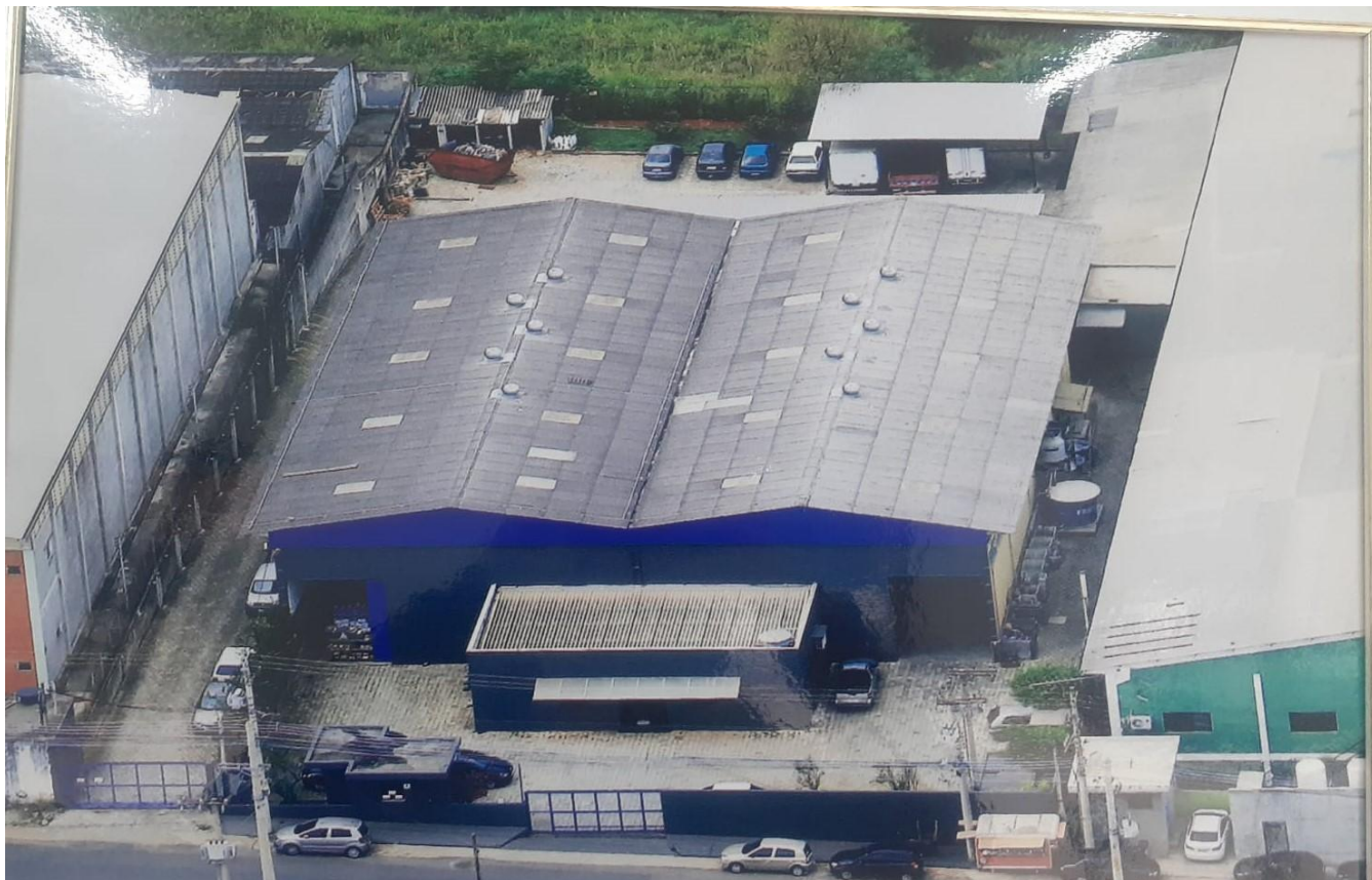
Fig. 15 – vista aérea da indústria RODILINE – unidade Suzano
