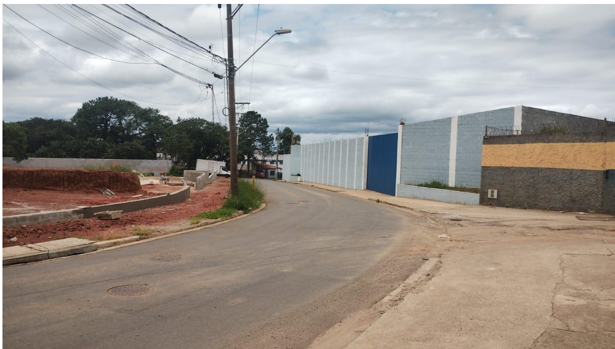
Figura 11: Rua Antônio da Surreição – Chácara Nova Suzano – em frente ao empreendimento
