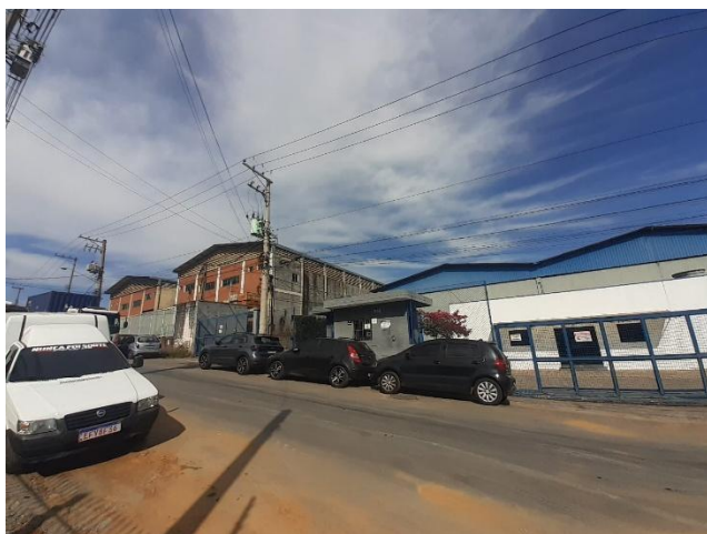
Fig. 16 – vista da entrada principal da RODILINE
