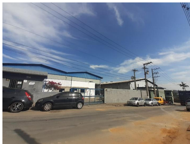
Fig. 17 – vista da entrada principal da RODILINE
