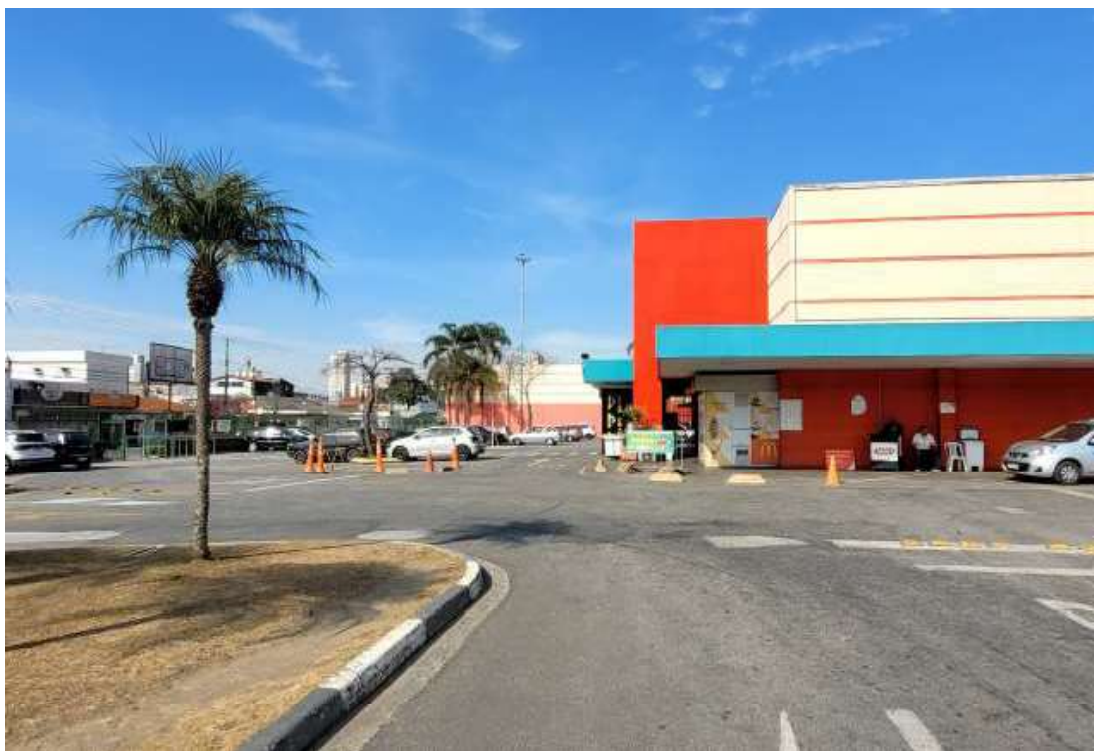
Foto 6 – Vista interna do estacionamento do Hipermercado (300 vagas).
