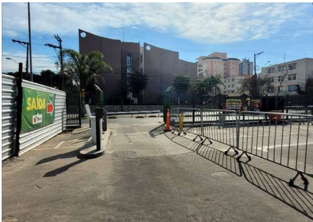
Foto 4 – Vista à partir do hipermercado da saída do estacionamento. Lado esquerdo da foto, nota-se a passagem de pedestre.
