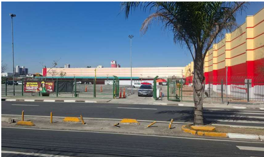
Foto 3 – Saída do estacionamento D'Avó Hipermercado. Nota-se, lado direito da foto, o muro que isolou os estacionamentos do Suzano Shopping e do D'Avó Hipermercado.
