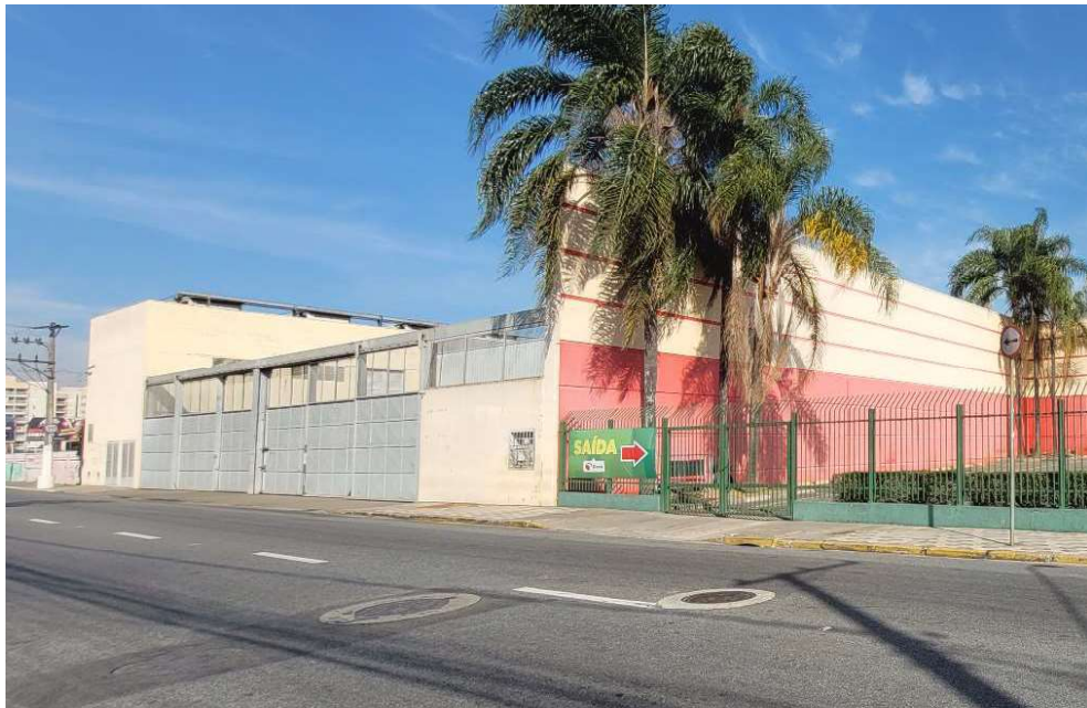
Foto 16 – Vista dos portões de entrada da área de descarga do Hipermercado, na divisa com o prédio principal.
