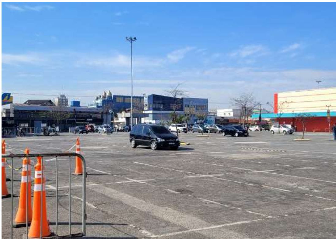
Foto 7 – Vista interna do estacionamento à partir da saída. Nota-se lado esquerdo da foto o Posto de Abastecimento.
