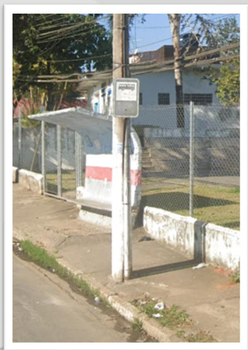
Imagem 4: Ponto de Ônibus 2. Elaborado por: Salle Consultoria e Engenharia.
