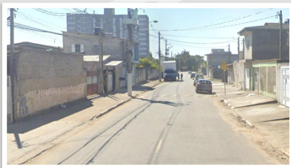
Imagem 2: Condições da Rua Luiz Affonso. Elaborado por: Salle Consultoria e Engenharia.
