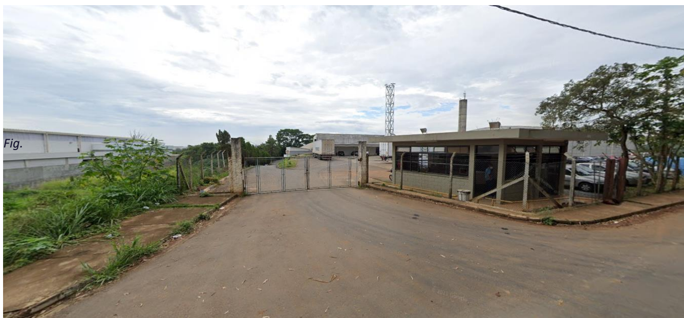
Fig. 15 – vista do acesso principal da indústria C.B.P.A. – unidade Suzano, fonte: google.com
