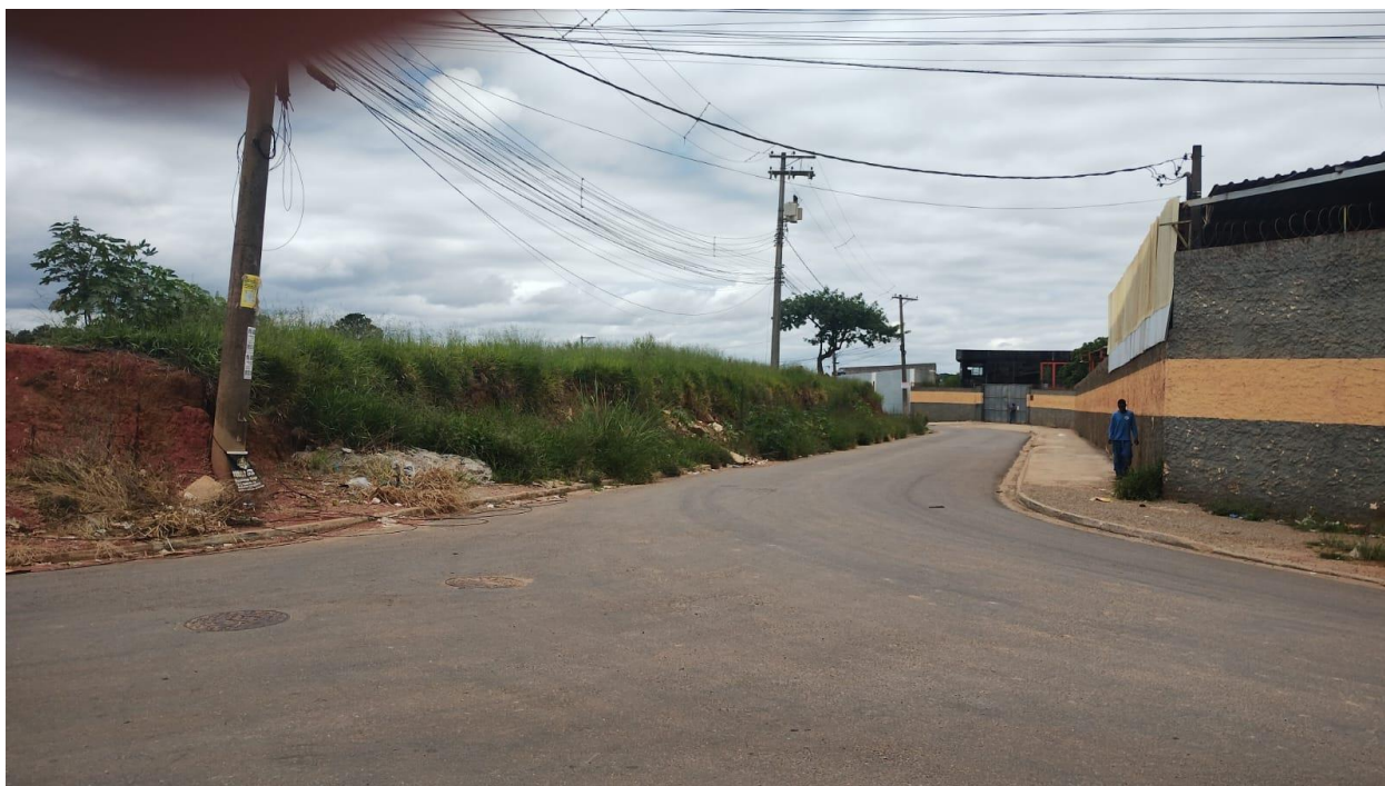
Figura 12: Rua Mitshuari Matsushita – em frente ao empreendimento
