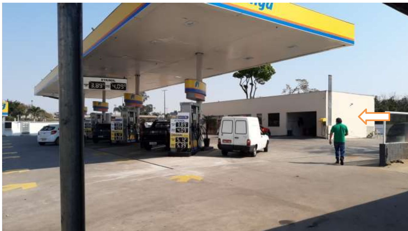
Localização da área de estudo – Posto de Serviços Automotivos e Comercio de Combustíveis Ab- Dhabi Ltda.(ilhas de abastecimento atuais) e edificação a ser demolida.
