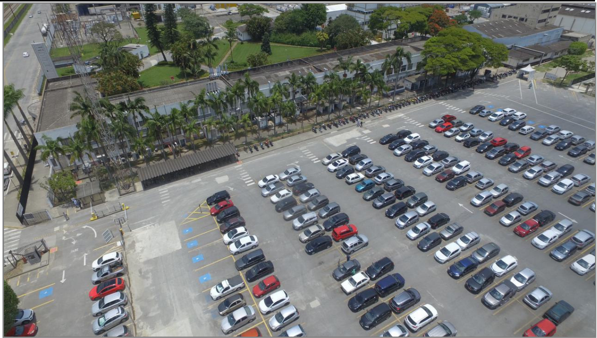
Figura 35 - Área interna para estacionamento de veículos dos colaboradores
