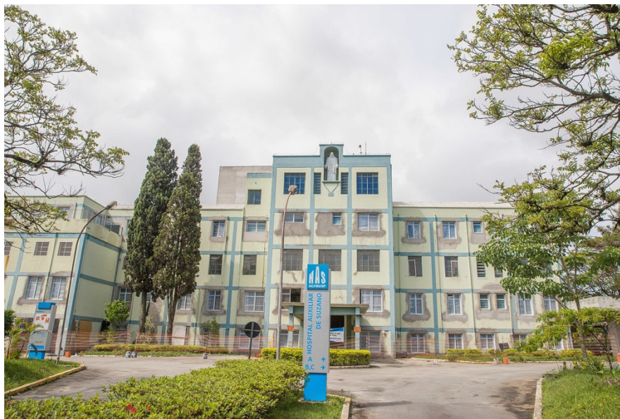
Figura 58 - Fachada do Hospital das Clínicas da Faculdade de Medicina da Univerdidade de São Paulo - HCFMUSP
