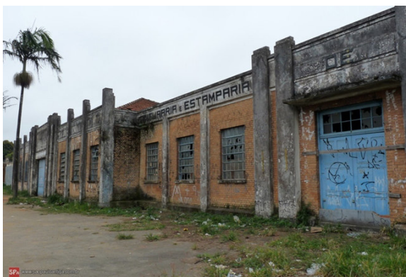
Figura 56 - Fachada Tinturaria Romanato Fonte: https://saopauloantiga.com.br/tinturaria-e-estamparia-de-tecidos-suzano-sa/
