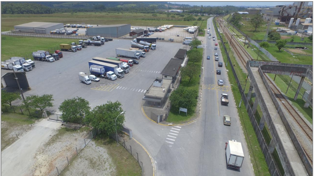
Figura 25 - Portaria de Recebimento
