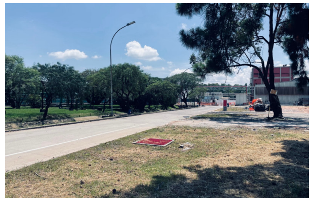
Figura 51 - Vista norte local da implantação Fonte: AAzevedo
