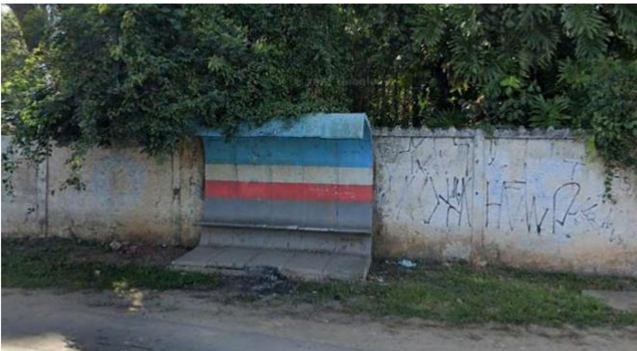
Imagem 18 – Abrigo existente na Estrada da Fazenda Viaduto altura do número 2325
