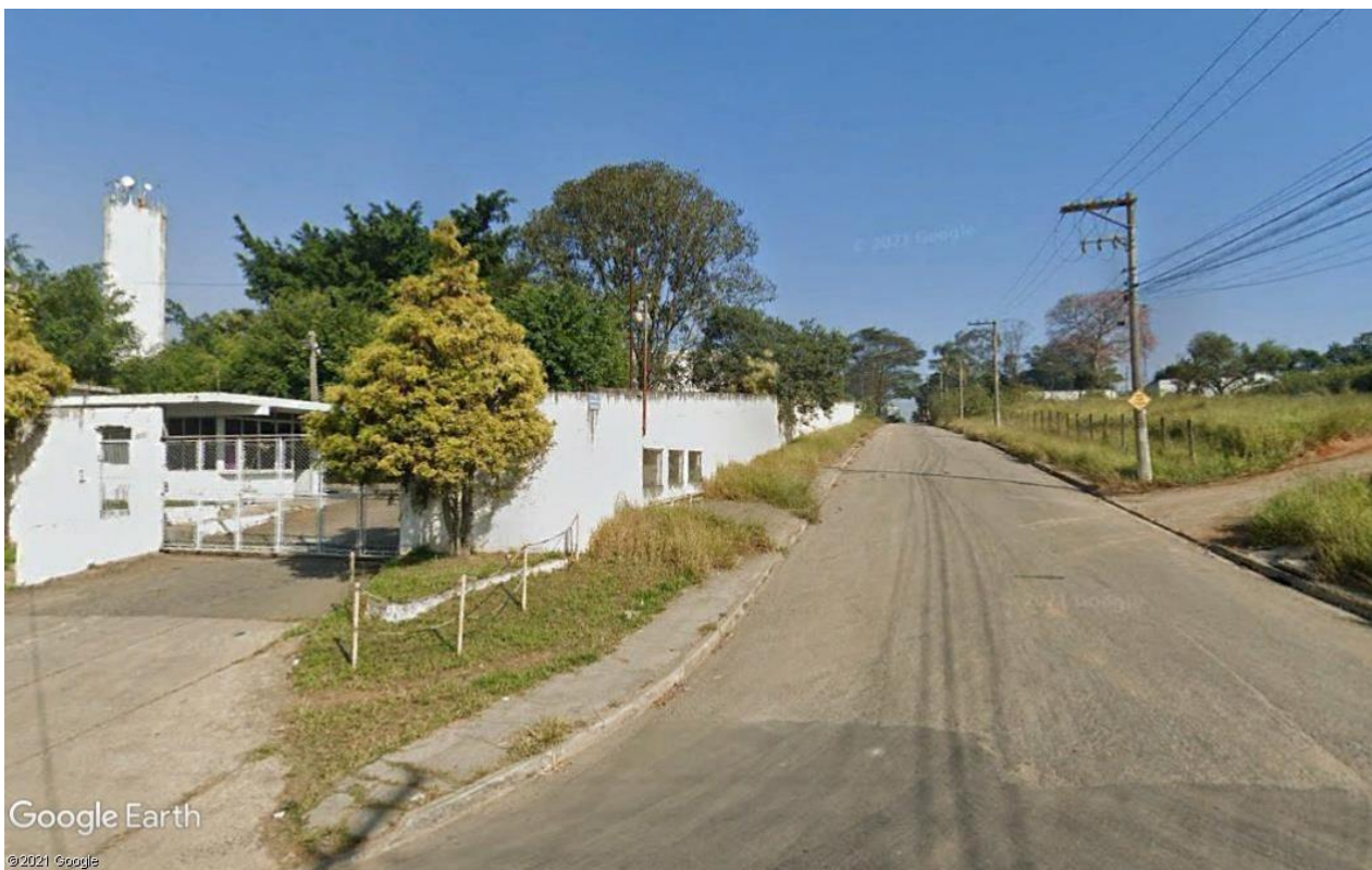
Imagem 8 – Vista da Rua Abrahão José Tannus / Fonte: Google Earth
