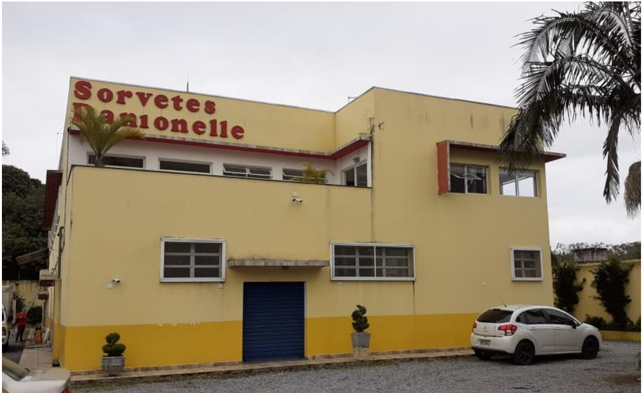
Figura 1: Fachada da empresa
