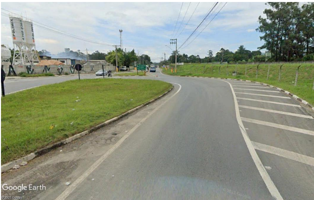
Imagem 6 – Vista da rotatória da Rodovia Índio Tibiriçá altura do número 3026, sentido Ribeirão Pires / Fonte: Google Earth
