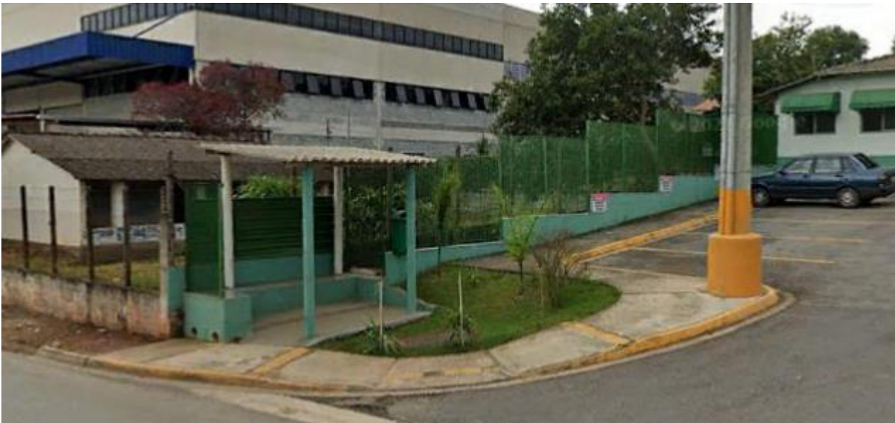
Imagem 17 – Abrigo existente na Estrada da Fazenda Viaduto altura do número 3070
