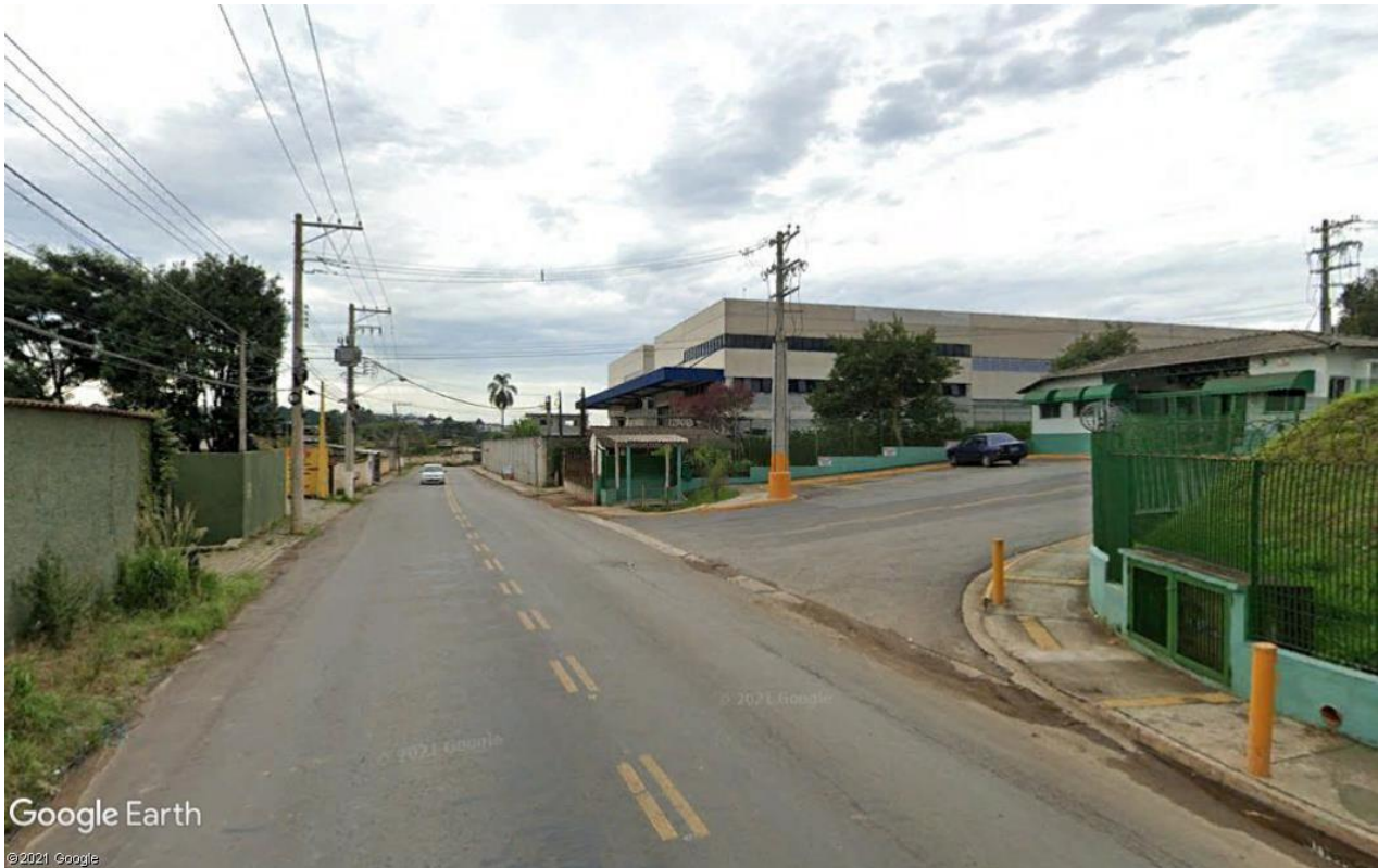
Imagem 7 – Vista da Estrada da Fazenda Viaduto / Fonte: Google Earth
