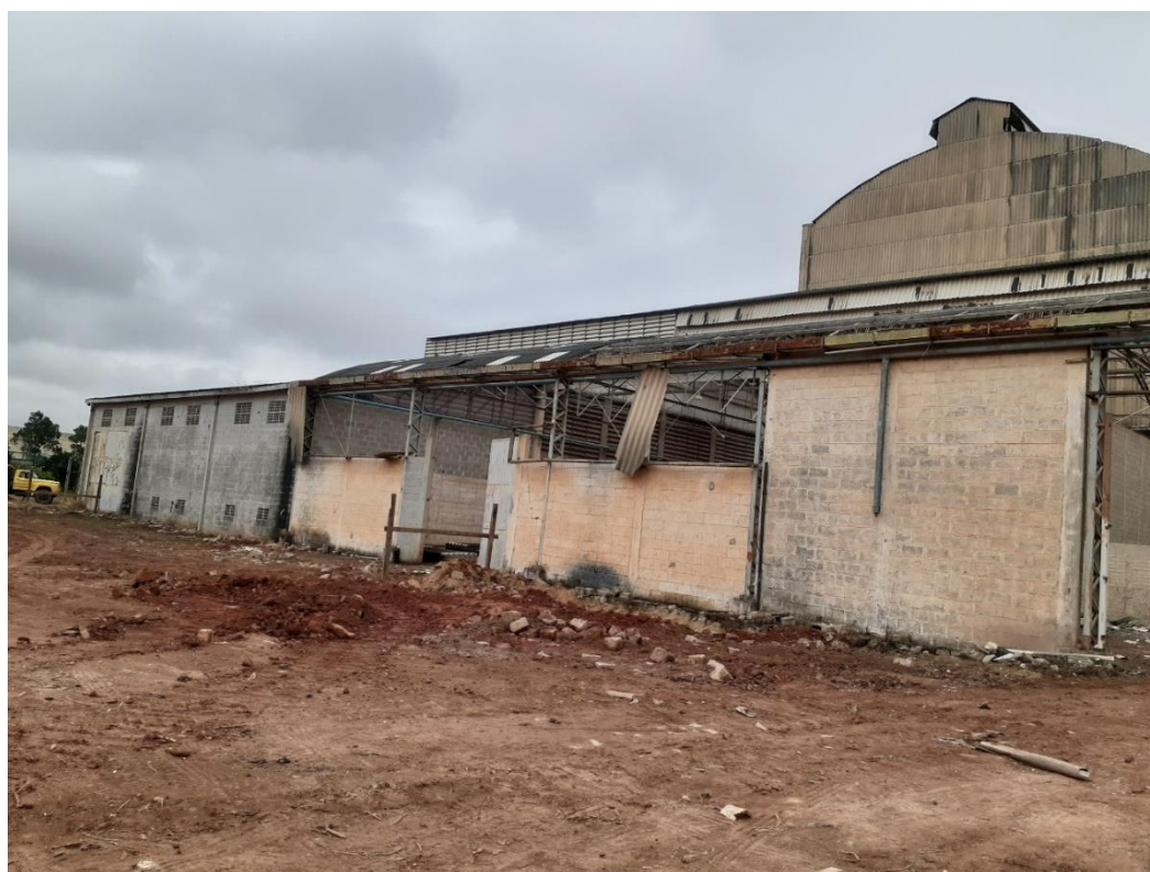
Foto 6 - visão lateral do prédio em reforma
