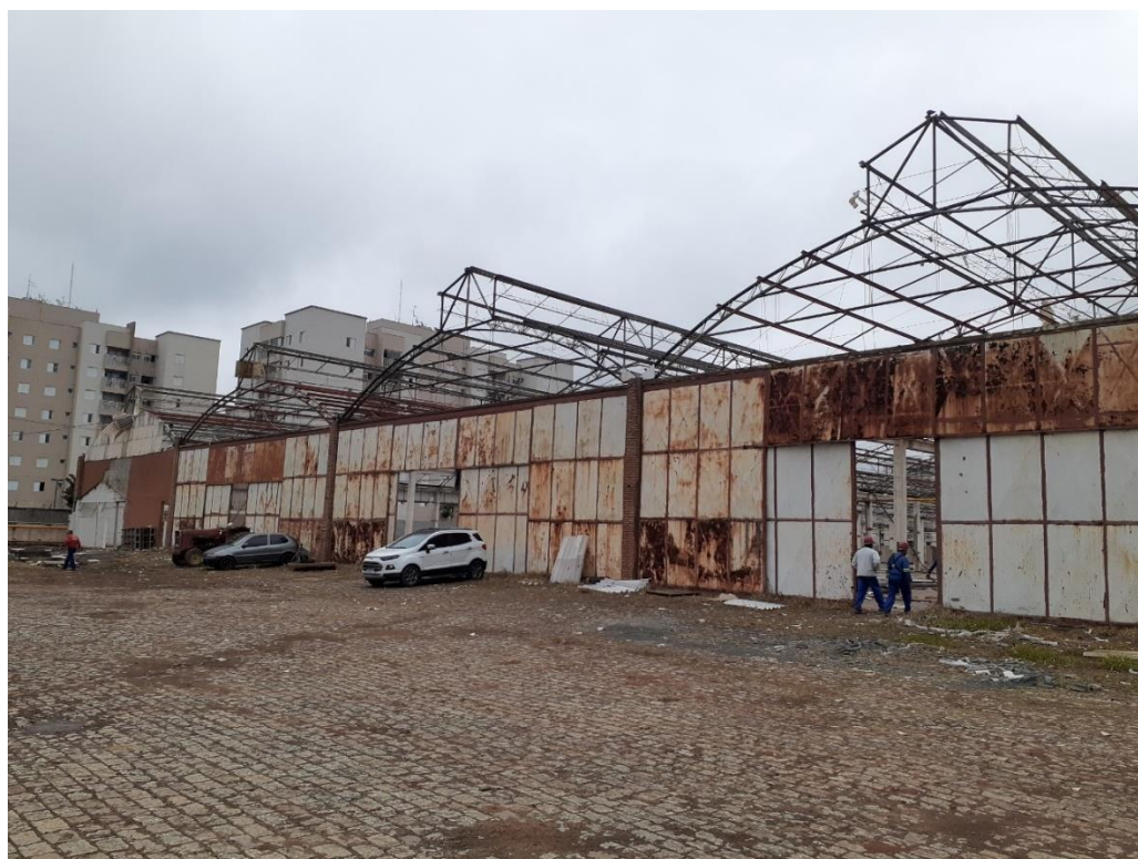
Foto 2 - recuperação de espaço ocioso e estruturas
