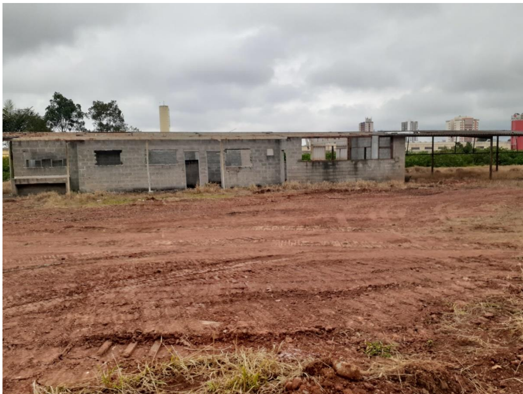
Foto 7 - áreas em demolição
