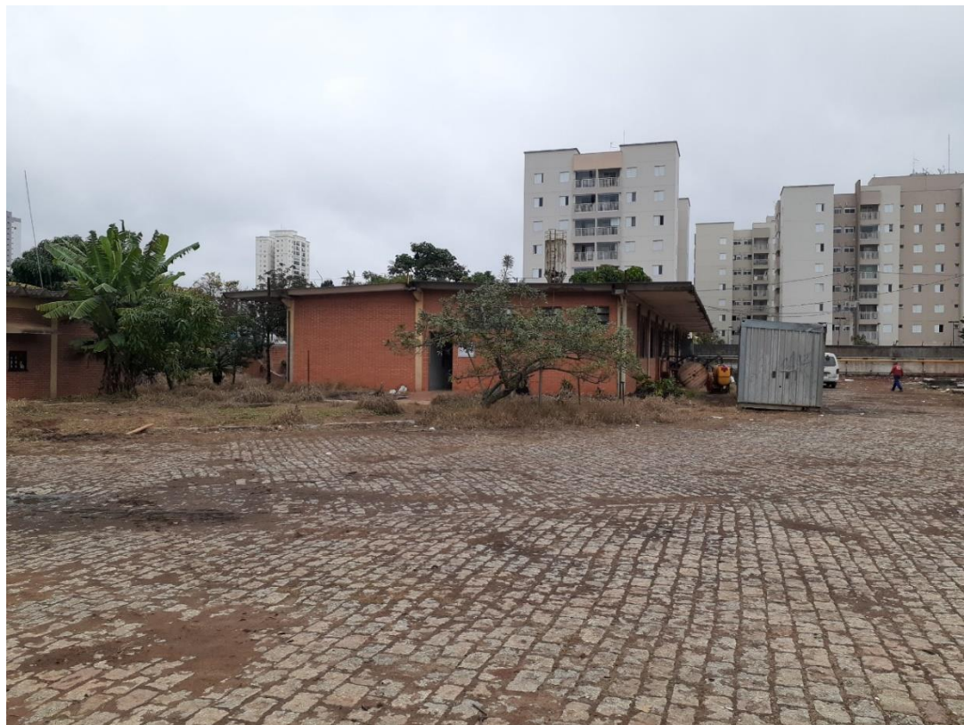
Foto 3 - área em reforma e ocupação residencial do entorno
