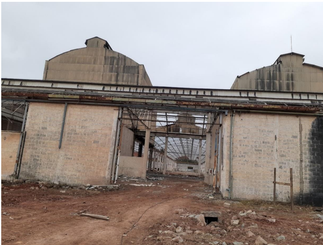
Foto 5 - fachada antiga e estruturas em recuperação
