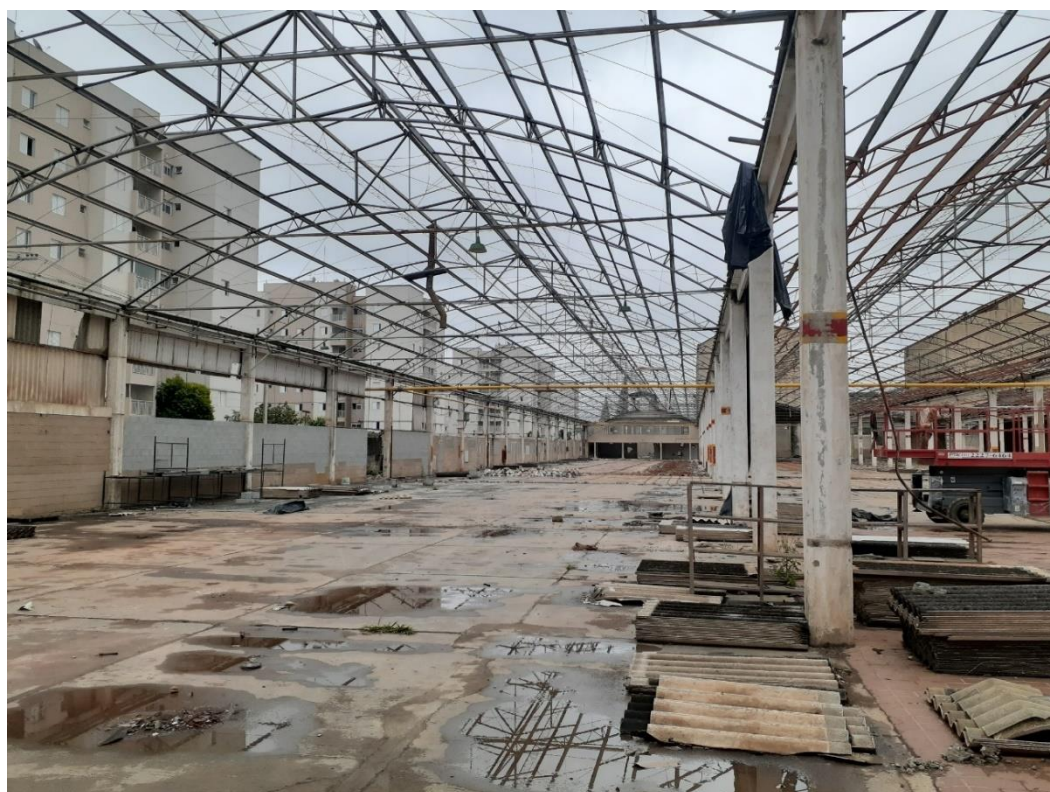
Foto 8 - Recuperação de estruturas metálicas
