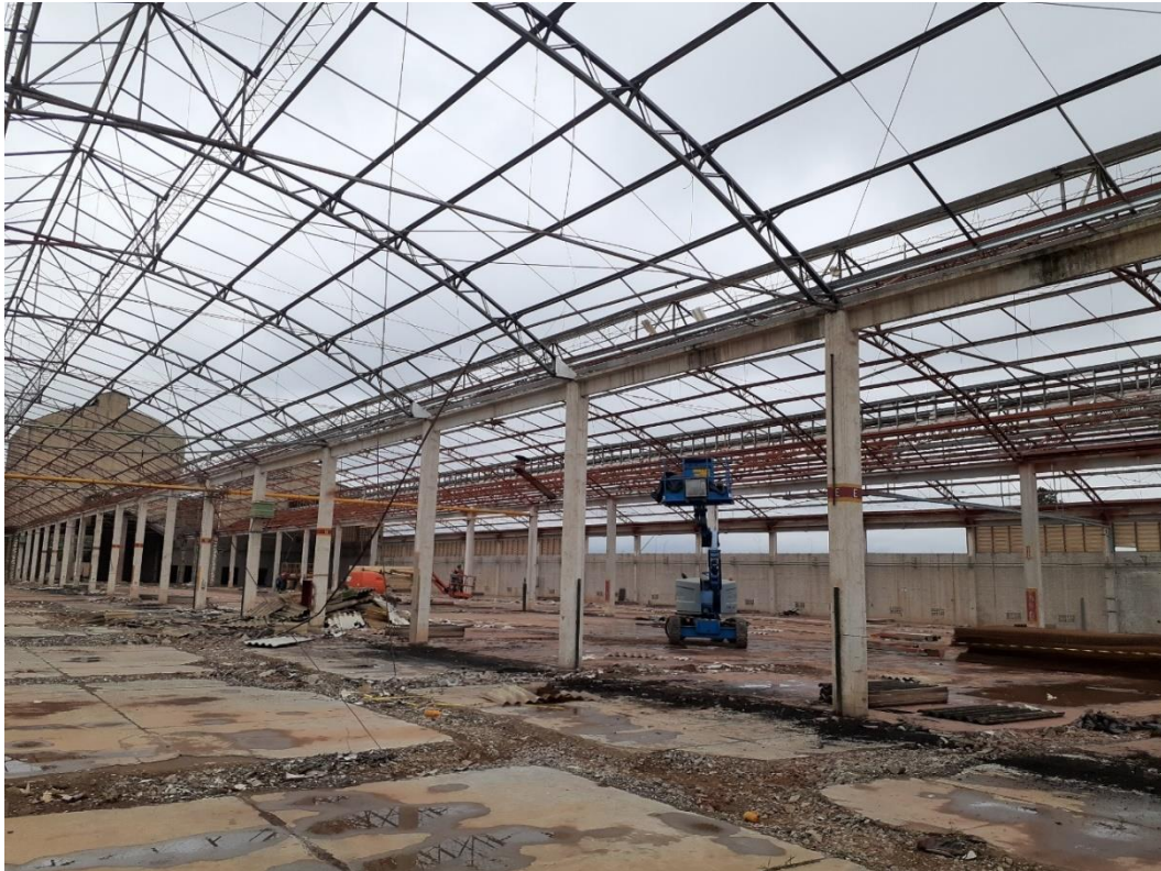
Foto 9 - Recuperação de estruturas metálicas
