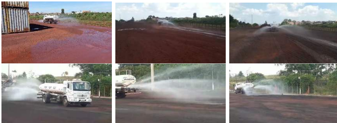
Imagens da implantação da aspersão de água.
