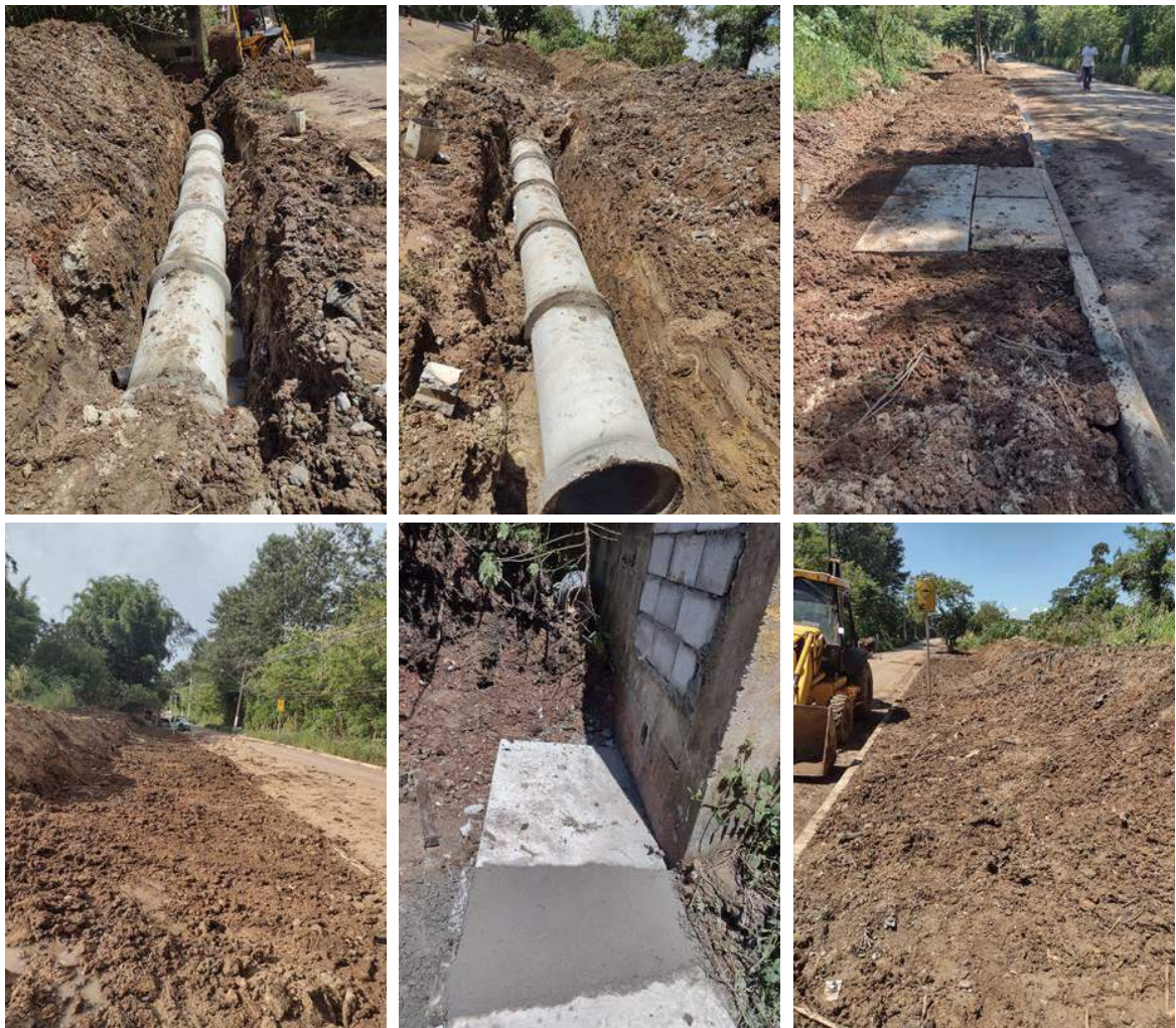
Registro fotográfico da obra de adequação da rede de drenagem Municipal executada
