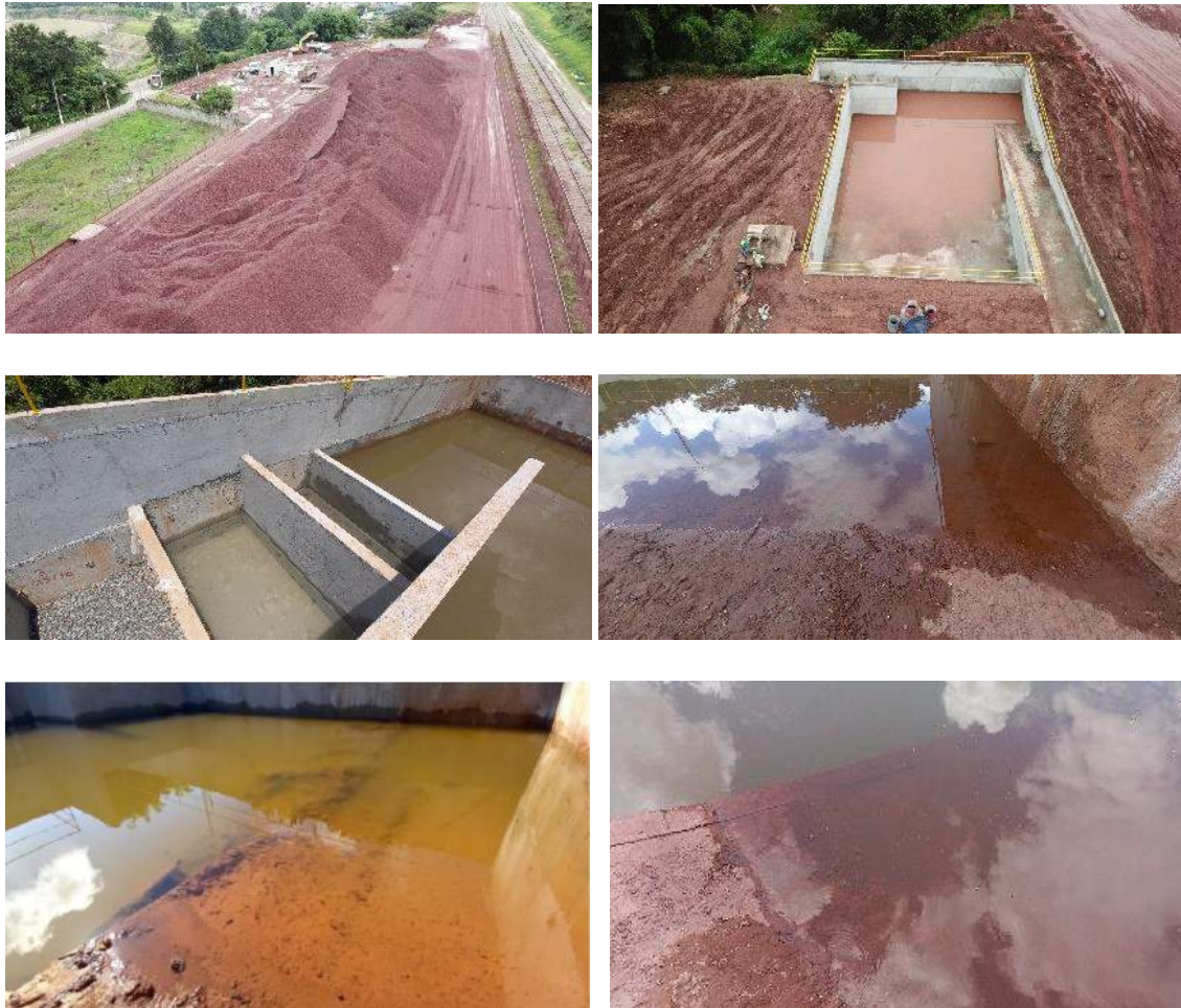
Imagens da implantação do sistema de drenagem, separador, decantação e filtro do particulado
