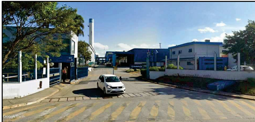
Figura 14 – Portaria 1 - Rua Brasfanta Fonte: Google Earth Pro
