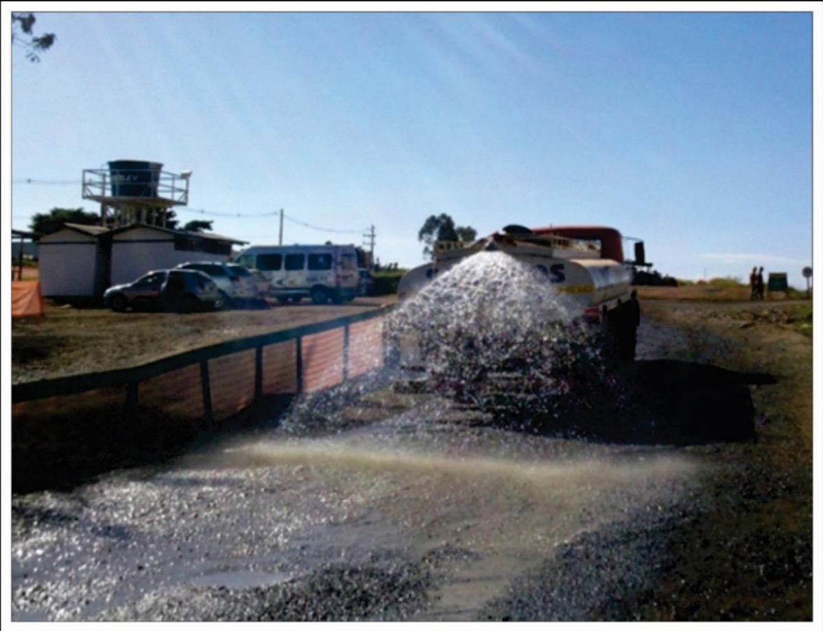
Figura 28. Exemplo de umidificação de solo na obra. Fonte: Global Vias
