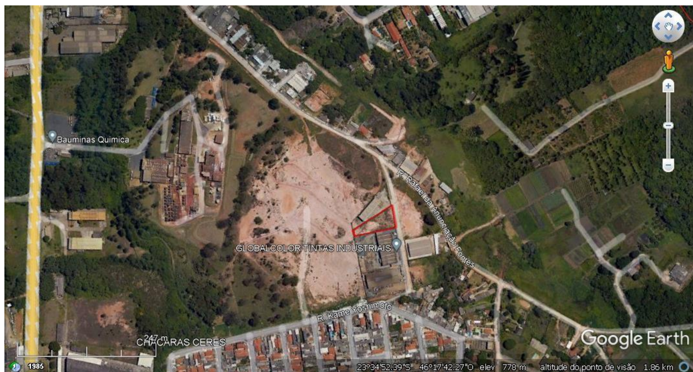
Figura 4- vista aérea do local do empreendimento
