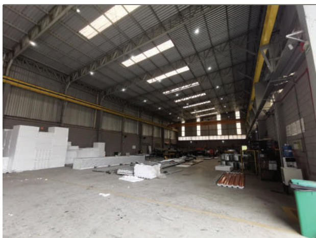
Vista ampla da parte interna do galpão
