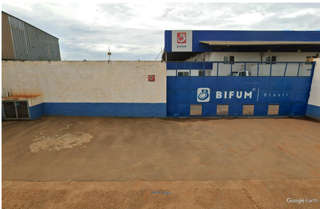
Imagem 8 – Recuo no acesso frontal com objetivo de não gerar impacto na via, ao fundo caminhão na área de expedição da empresa
