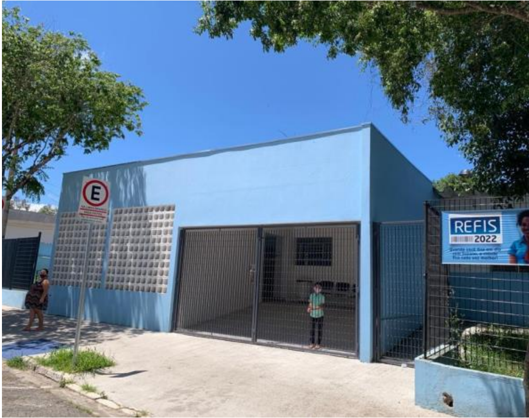
Imagem 6 – UBS Tabamarajoara que foi reformada e ampliada
