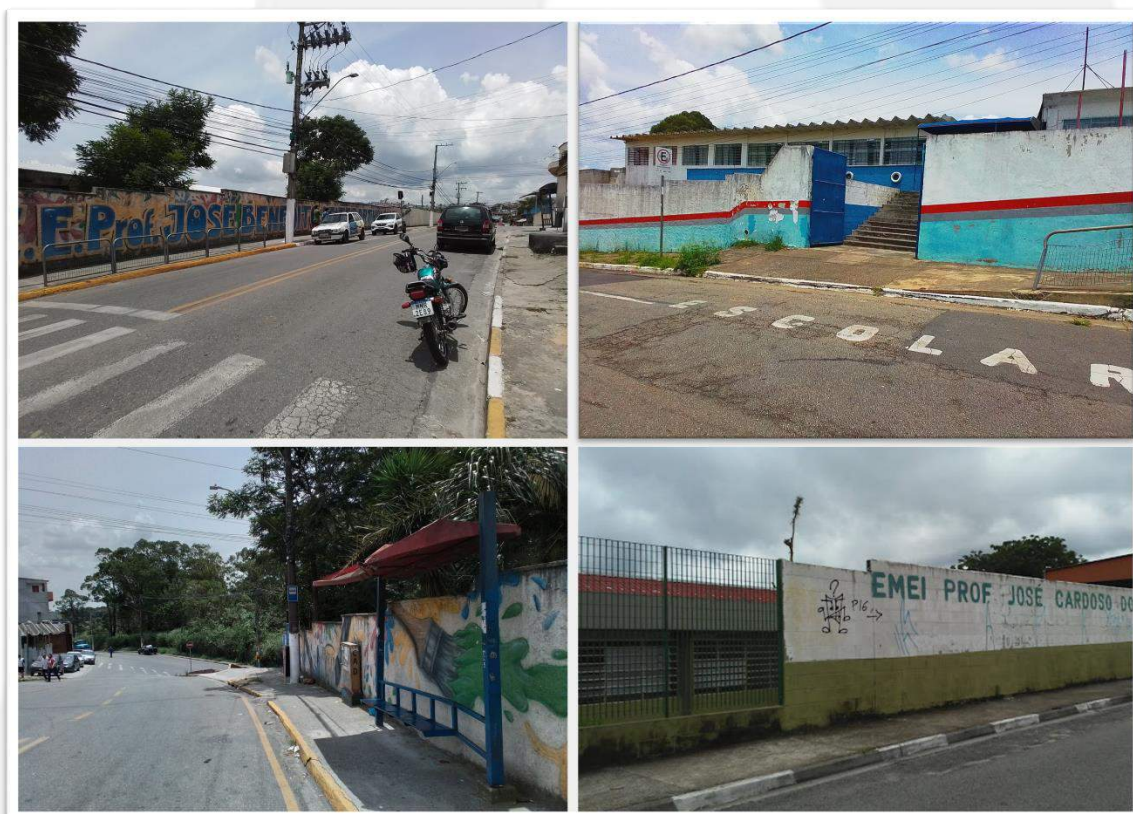
Imagem 3: Fachadas das Escolas: José Benedito (foto 1 e 3), Ruy Ferreira Guimarães e José Cardosos dos Santos Fonte: Salle Engenharia
