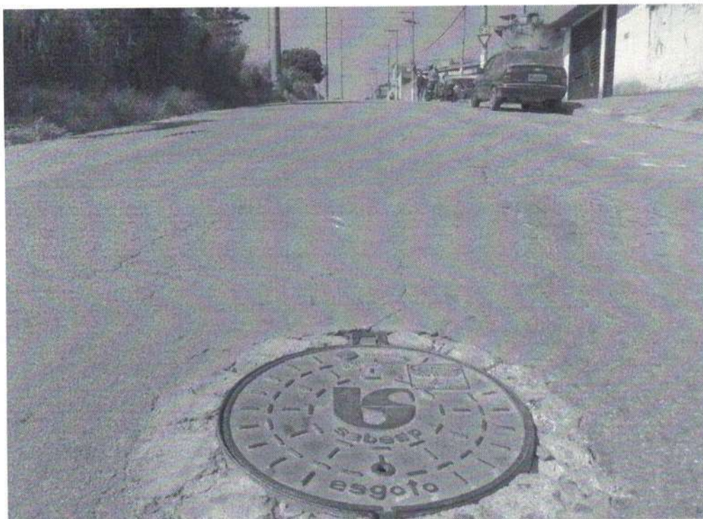
Figura 49: Foto E1 - Sistema de Coleta e Afastamento de Esgoto existente, não interligado ao Sistema de Tratamento ETE – Suzano Fonte: Ambientium (2018)
