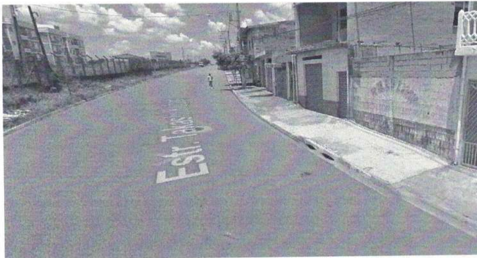
Figura 50: Sistema de Drenagem existente (bocas de lobo) Fonte: software Google Earth Pro (2018) modificado por Ambientium
